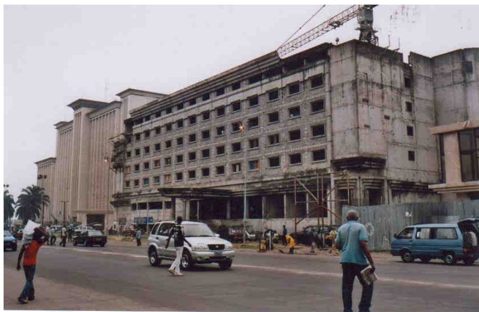
.L'ex hôtel Régina.(Chantier à l'arrêt depuis plusieurs années).
